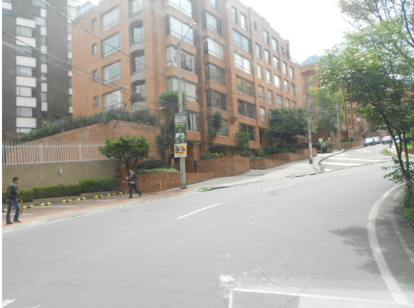
FOTO 3. ELEMENTOS INSTALADOS SOBRE POSTE EN LA CARRERA 5 CALLE 74 del 08-03-2014
